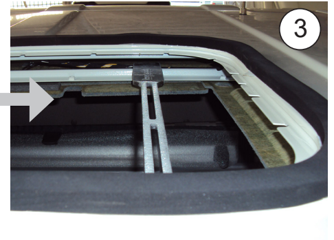
Vista dall'esterno della cabina
